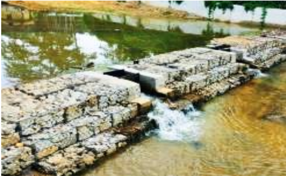
شکل ۱. نمایی از کاربرد سرریز گابیونی و بندهای مصنوعی تأخیری در رودخانه ها
