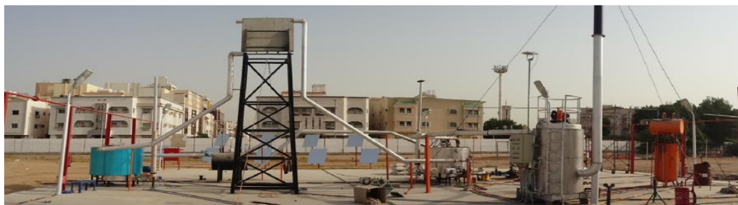
(a) برج خورشیدی از ابوحمده و النفای میجهز به مخازن ذخیره‌سازی حرارتی، گیرنده و برج و مبدل حرارتی [۲۰]
